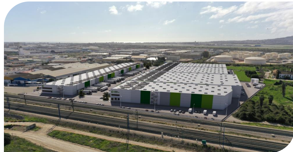
Málaga Green Logistics Park. Málaga, España.
